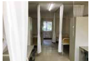
カーテン敷設状況
